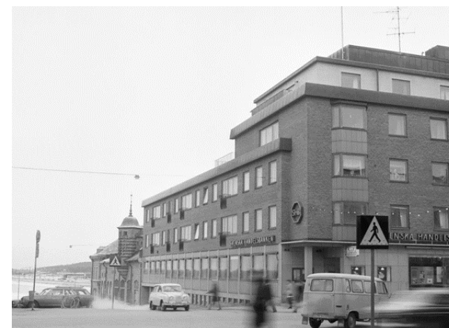
Elverket längst ner på Nygatan inför rivning 1971
