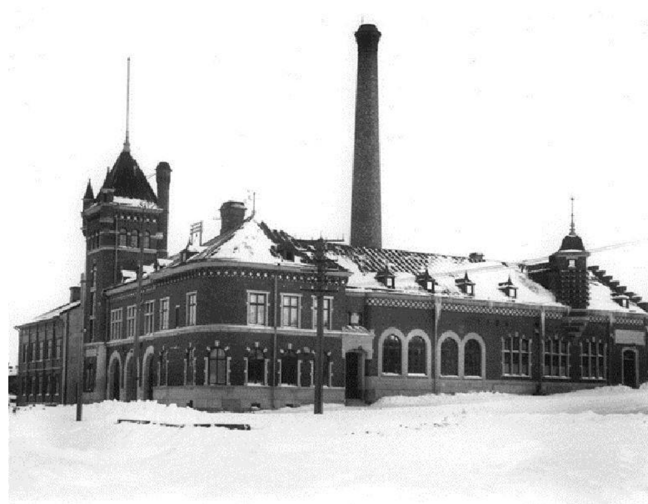
Luleå brand- och polisstation samt elverk 1899
