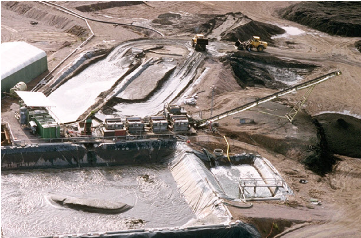
Figur 13: Avvattning i silbandspressar och vattenrening i en flocknings- och flotationsanläggning. Fotografi från saneringen av Järnsjön i Emån.
