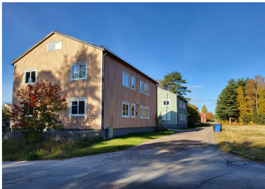
Vy längs Börstskärsgatan mot nordväst med Kv. Magneten till vänster. De avrivna tomterna i Kv Järnet till höger, bevuxna med gräs och träd.
