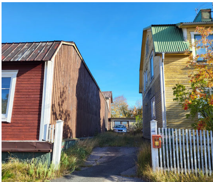
Vy mot infart med grindstolpar och spjälstaket. Karaktärsfullt gårdshus till vänster, bostadshus från 1920-30-tal till höger. Kvarteret Valverket.
