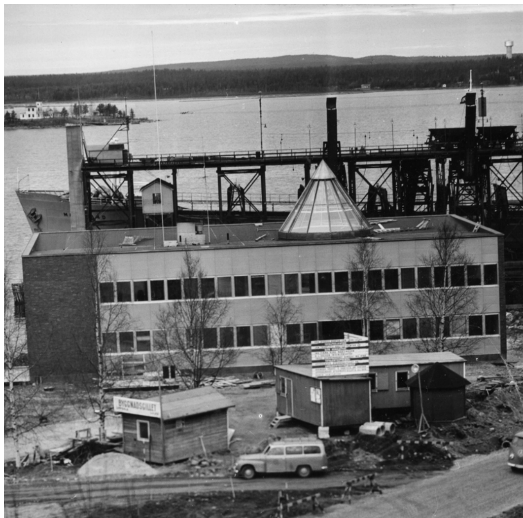
LKAB:s kontor vid Svartön under uppförande år 1961. I bakgrunden syns Bergnäset och Gråsjälören. Källa: Luleå kommuns stadsarkiv
