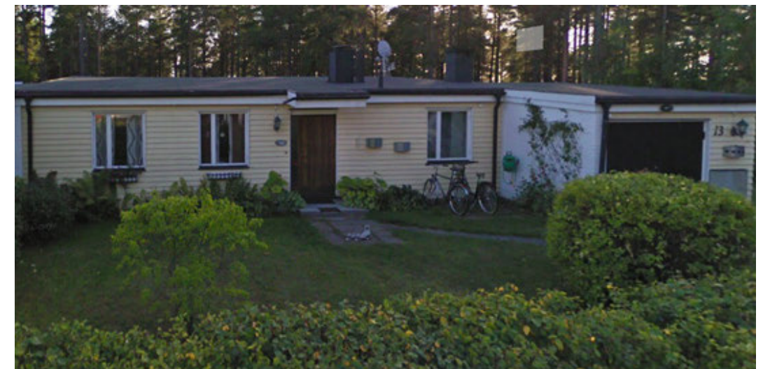
Skärmtak som funnits på ett av kedjehusen, möjligen har detta varit del av den ursprungliga utformningen på kedjehuslängan i sydväst.
