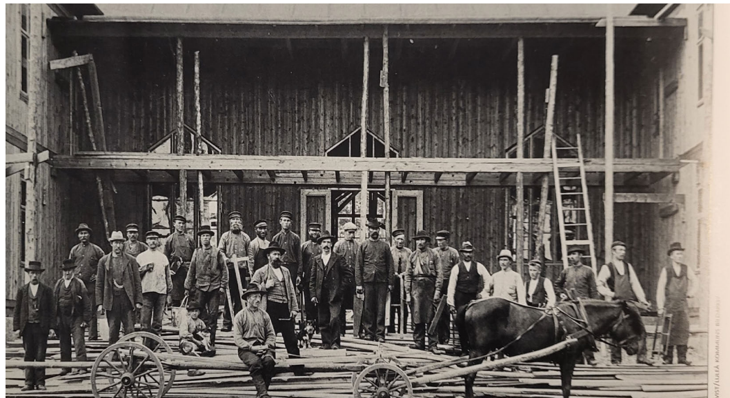
Foto från bygget av Folkets hus, Blackis (ursprungligen känt som NVB-huset) den 1 augusti år 1900. Byggnaden uppfördes av Nykterhetsvännernas Byggnadsförening. Källa: Staden bortom staden: Boken om Svartöastaden
