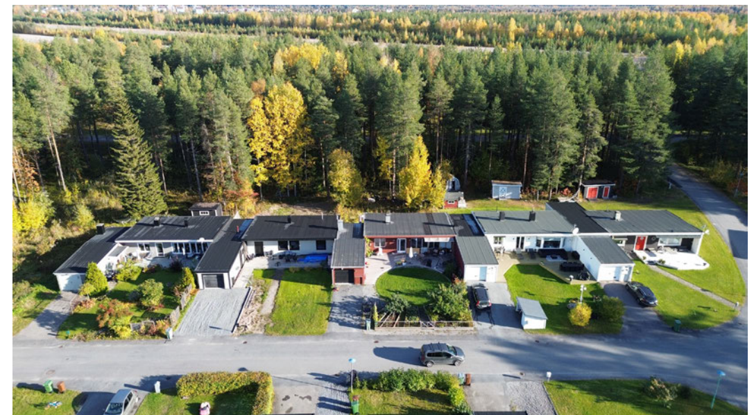
Flygvy mot längan med kedjehus i nordöst.
