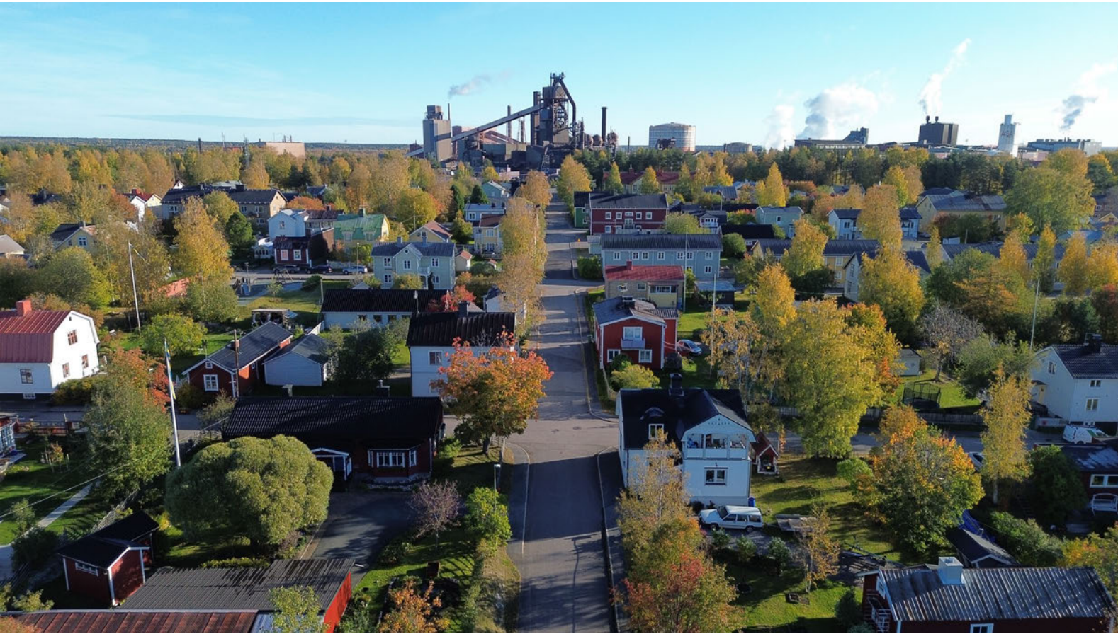
Figur 1 Flygvy över del av Svartöstaden från Gråsjälfjärden med järnverket på krönet i fonden av Bältesgatan.
