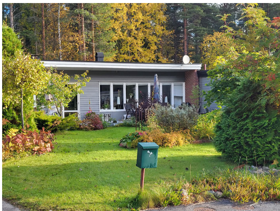
Del av kedjehus med i huvudsak bibehållet utseende avseende material och detaljer. Liggande panel på förvandring. Höga smala fönster i fönsterband, och omålad gavel av rött tegel.
