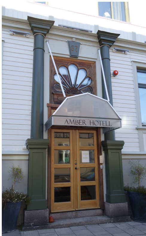
Bild 12: Entrédörren mot Stationsgatan med det anmärkningsvärda överljusfönstret. Skärmtaket och dörren i sig omfattas inte av en preciserad varsamhetsbestämmelsen men det generella varsamhetskravet gäller. Skärmtaket har tillkommit senare. Byggnaden är utformad med snickerier och lister såsom bilderna visar och ska bibehållas.
