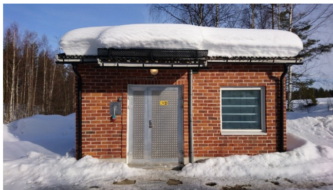
Figur 1. Bild på vattenverket i Niemisel.
