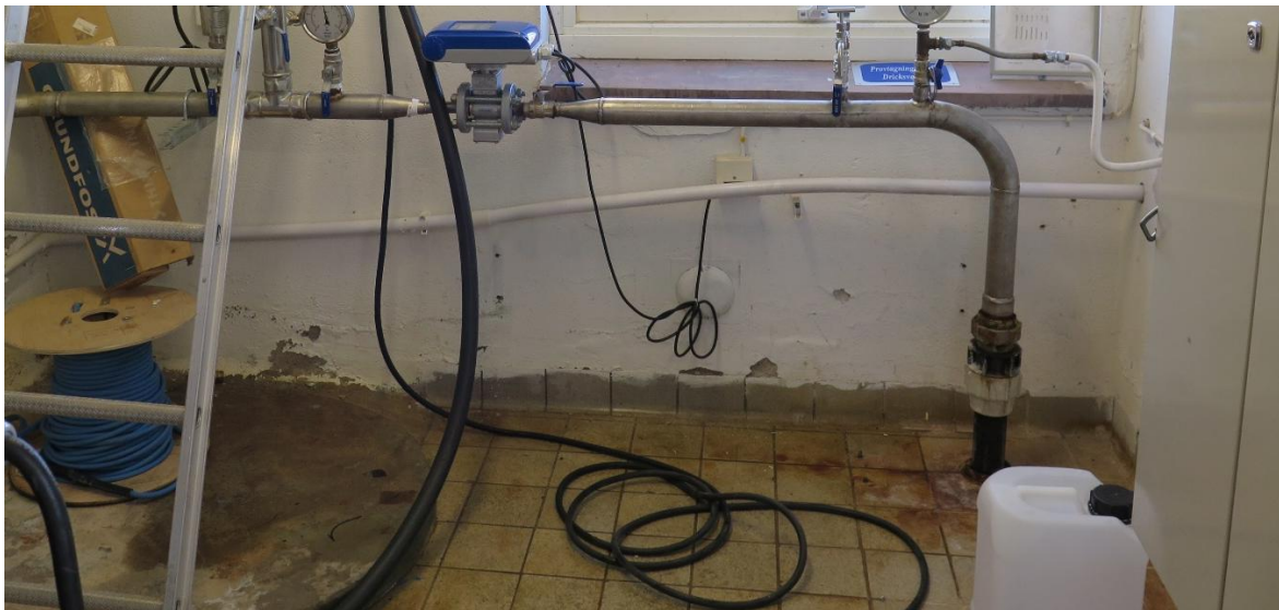
Figur 6. Vagg håller på att vittra sönder. Golvkakel slitet.
